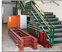
Neue Stahlträger wurden bereits eingebaut, weitere warten darauf.
