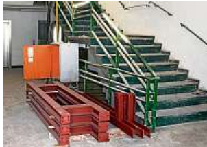
Neue Stahlträger wurden bereits eingebaut, weitere warten darauf.
